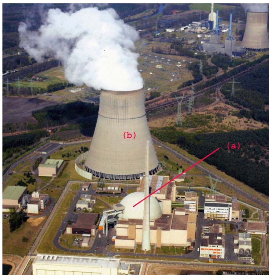
Figure 23 Das Kernkraftwerk Lingen/Ems
